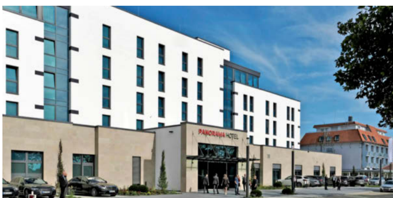
Direkt neben dem alten Gebäude (rechts) steht das neue Panoramahotel, das am Dienstag offiziell eröffnet wurde und grandiose Ausblicke bietet. Foto: Dennis Mugler
